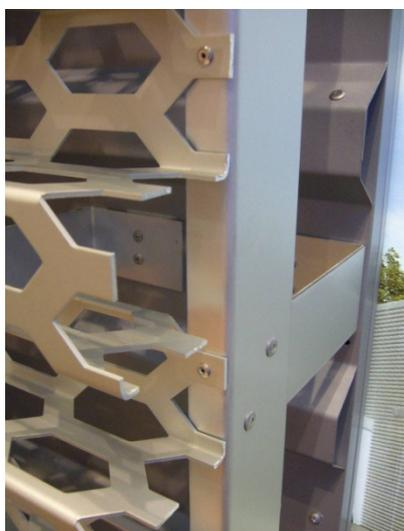
Beispiel: Vernietung Aluminiumprofil an Unterblech + Vernietung Lochblechpaneel an Aluprofilträger
