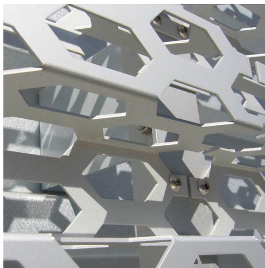
Beispiel einer Verschraubung der Lochblechpaneele auf dem Aluprofil
