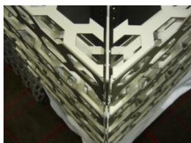
Bild links/Mitte: Eckleisten mit Gehrungsschnitten und Zahnleisten als Schutz
